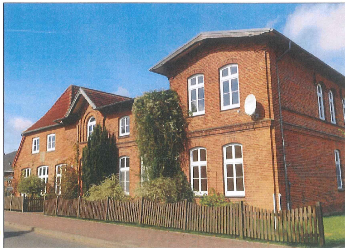
Die alte Schule in Kalübbe soll einem Neubau eines Dorfgemeinschaftshauses mit Kindergarten weichen. Für den Neubau bewilligte die AktivRegion Schwentine-Holsteinische Schweiz Fördermittel.
